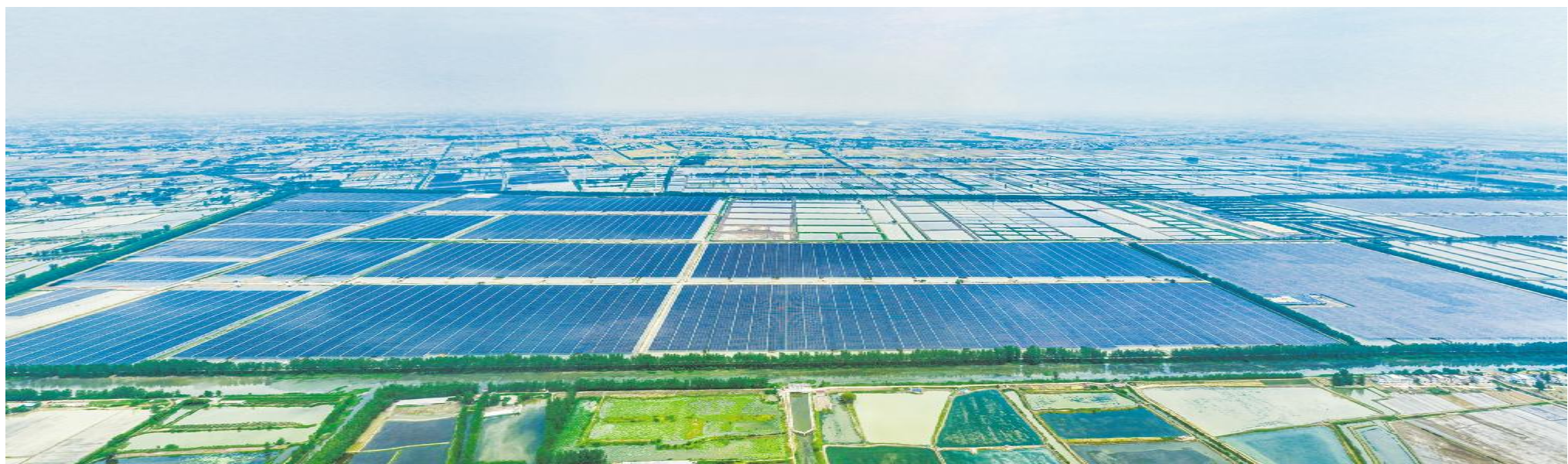
通威天门“渔光一体”项目
